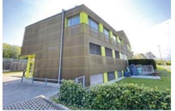
LUTRY – Immeuble administratif et artisanal
