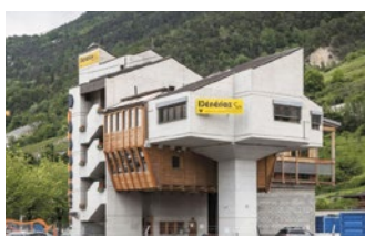
5. Dénériaz SA Sion / construction générale de bâtiments et d'ouvrages de génie civil 100-199 employés
